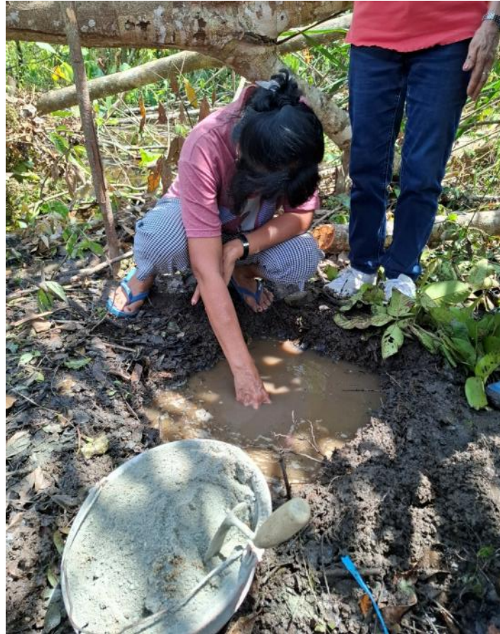
eerste deel van de fundering gelegd
