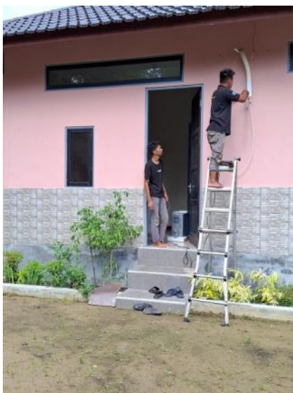
airco plaatsen in gemeenschapshuis
