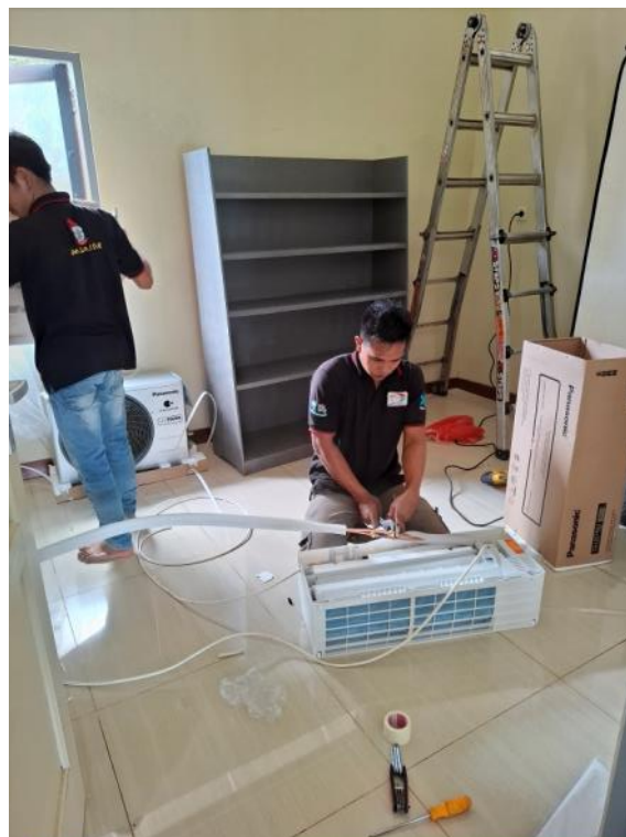
installeren van de airco
