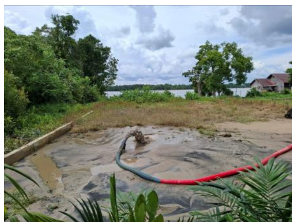
terrein schoonmaken dat grenst aan de rivier stug gras en stronken verwijderen en opvullen met zand
